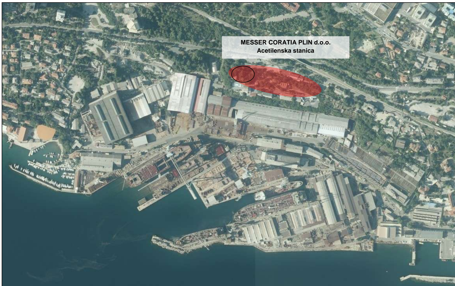
Slika 8: Ortofoto snimak lokacije postrojenja
